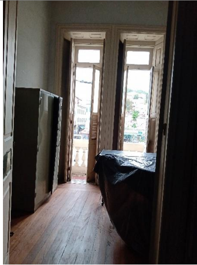
Sala 24 – Pavilhão de aulas – Prédio anexo - 2º andar
