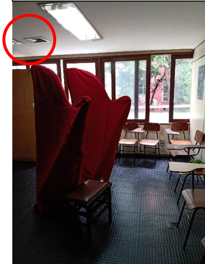
Sala 24 – Prédio 2 - 2º andar
