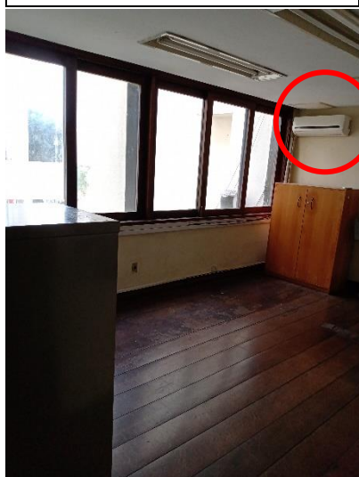
Sala 33 - Prédio 2 - 2º andar
